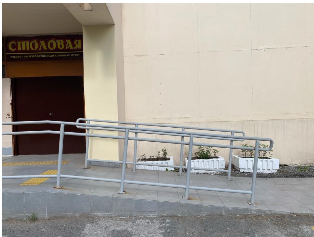
Входная группа (крыльцо) здания столовой оснащено пандусом
